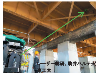
図. 装置からレーザーを照射して鋼板の浮きを検査
